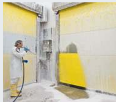
V 2515 Food L Einfache Reinigung: Welle, Seitenteile und Schaltschrank sind komplett aus Edelstahl.
